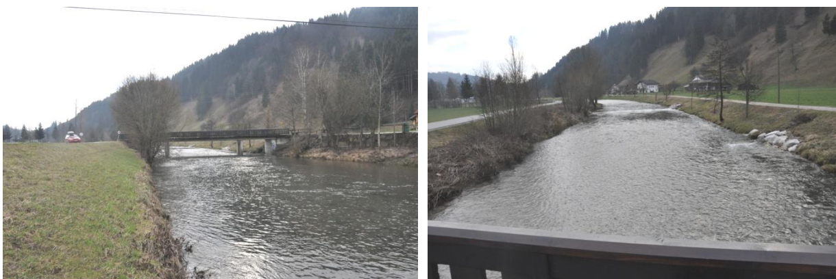
Slika 1, 2: Sora na območju mostu na cesti Dobračeva-Ledinca (prerez Sore F14.1). Pogled na most v gorvodni smeri (levo), pogled na strugo z mosta v gorvodni smeri (desno).
