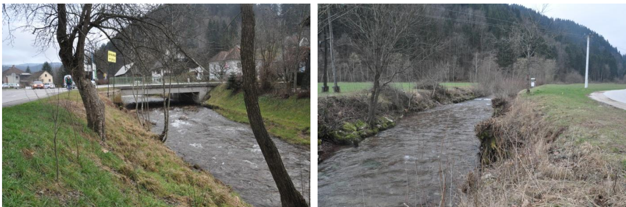
Slika 13, 14: Račeva. Most na Jobstovi cesti (levo), struga na območju križanja z obvoznico slikana v dolvodni smeri (desno).
