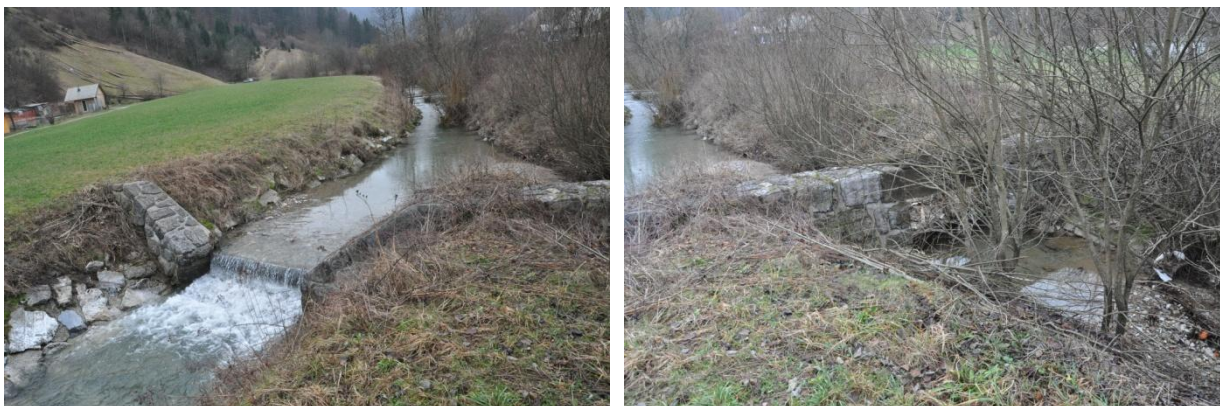
Slika 15, 16: Razedlilni objekt na Osojnici. Vtok v novo strugo (levo), vtok v staro strugo (desno)
