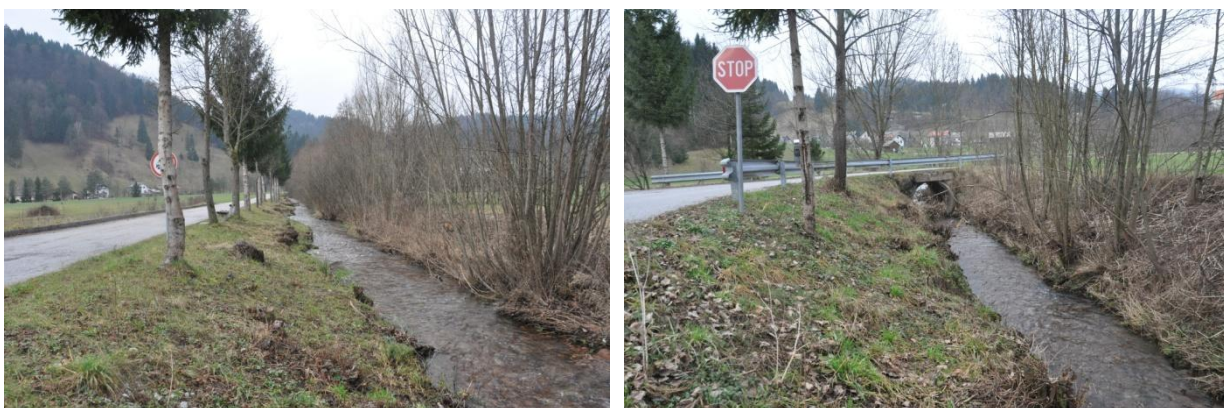
Slika 11, 12: Rakulka. Struga na območju gorovodno od križanja z obvoznico (levo), prepust na izlivu v Soro \Phi 200\text{cm} (desno), oboje slikano v dolvodni smeri.
