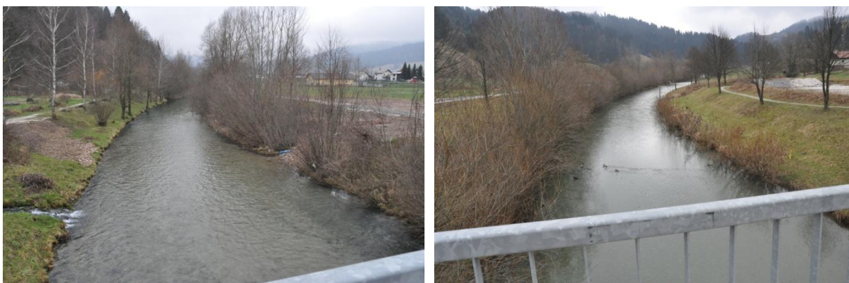
Slika 5, 6: Sora na območju mostu na Jobstovi cesti (prerez Sore F30,3). Pogled z mostu v dolvodni smeri (levo) in gorvodni smeri (desno).
