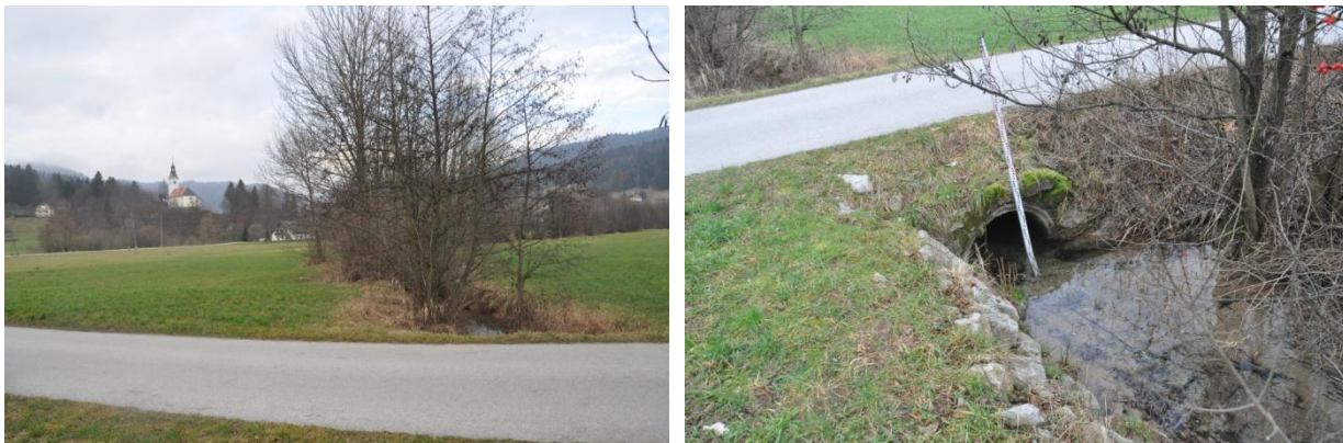
Slika 9, 10: Pritok J na križanju s cesto Dobračeva-Ledinica. Struga v dolvodni smeri (levo), prepust pod cesto \Phi 80\text{cm} (desno)
