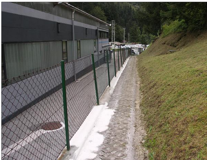
Slika 5: zaledje proizvodne hale z muldo na stiku pobočja in podpornega zidu
