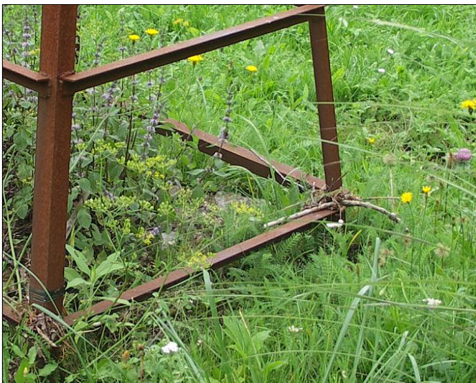
Slika 14: sledi poplave na železni konstrukciji v bližini objekta na desnem bregu
