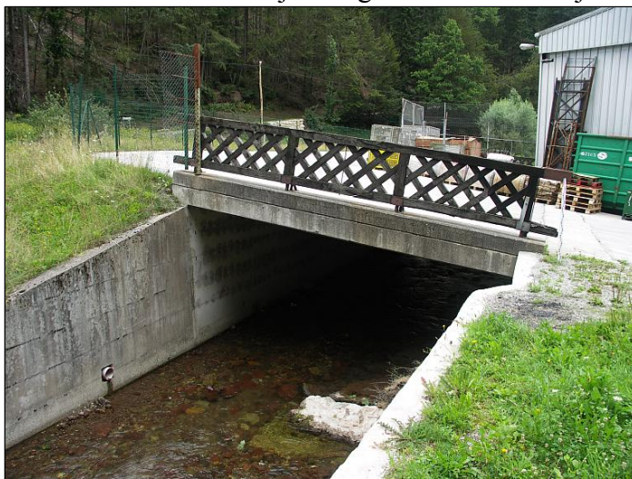
Slika 1: premostitev nad obratom Termopola
